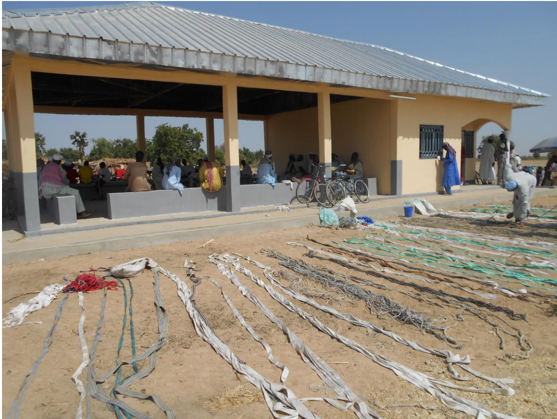
Photo 4 : Bureau + hangar du marché à bétail de Dargala
